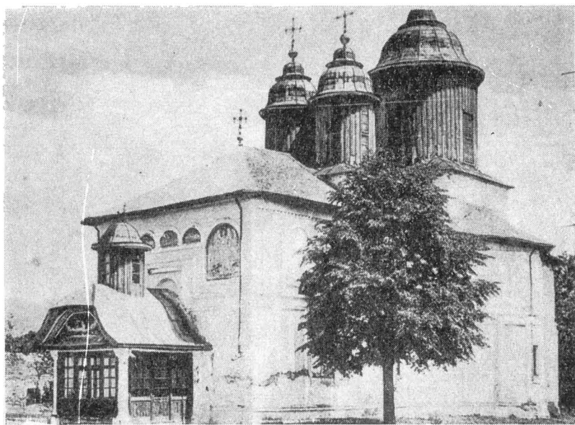
Mănăstirea Brebu înainte de ultima restaurare.
